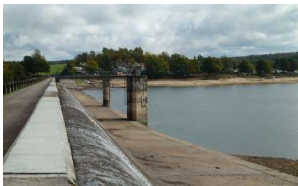
Barrage de Bouzey – Photographie DDT 88
