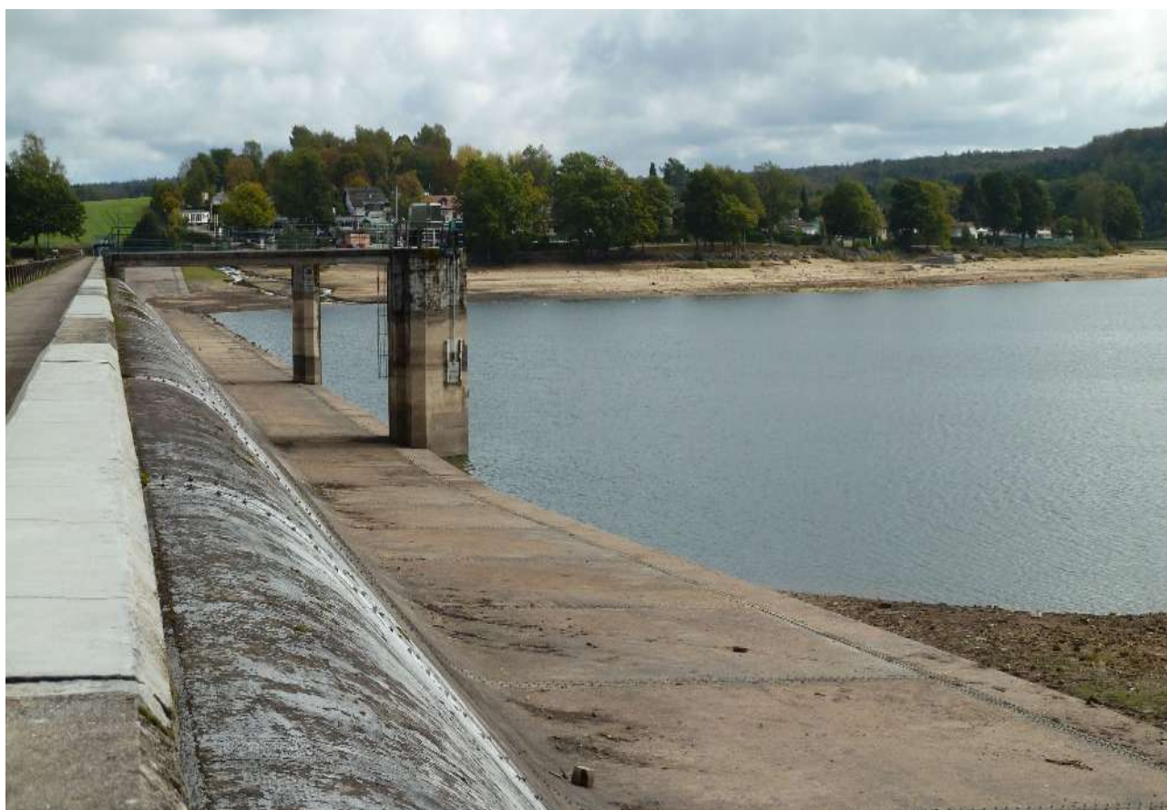
Barrage de Bouzey – Photographie DDT 88
