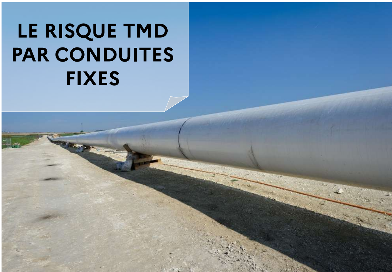
Pipeline – Photothèque MTE
