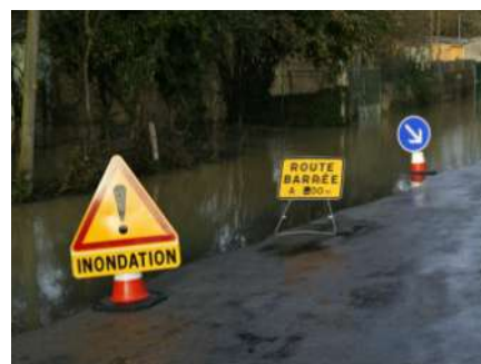
Route inondée Photographie MTE
