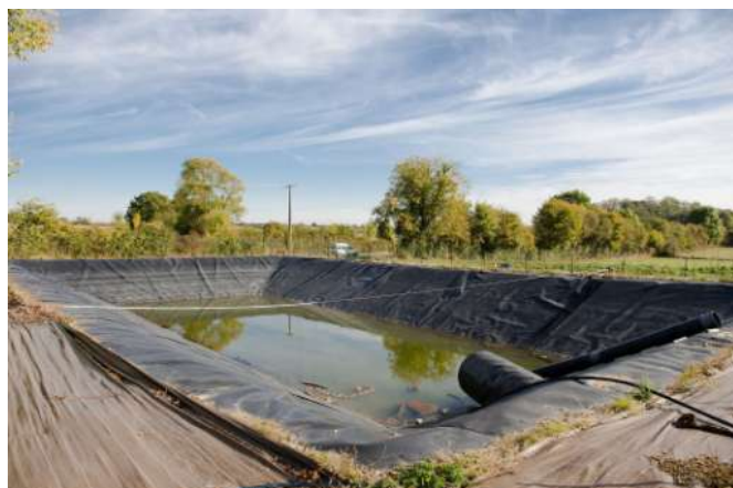
Bassin de rétention d'eau – Photographie MTE
