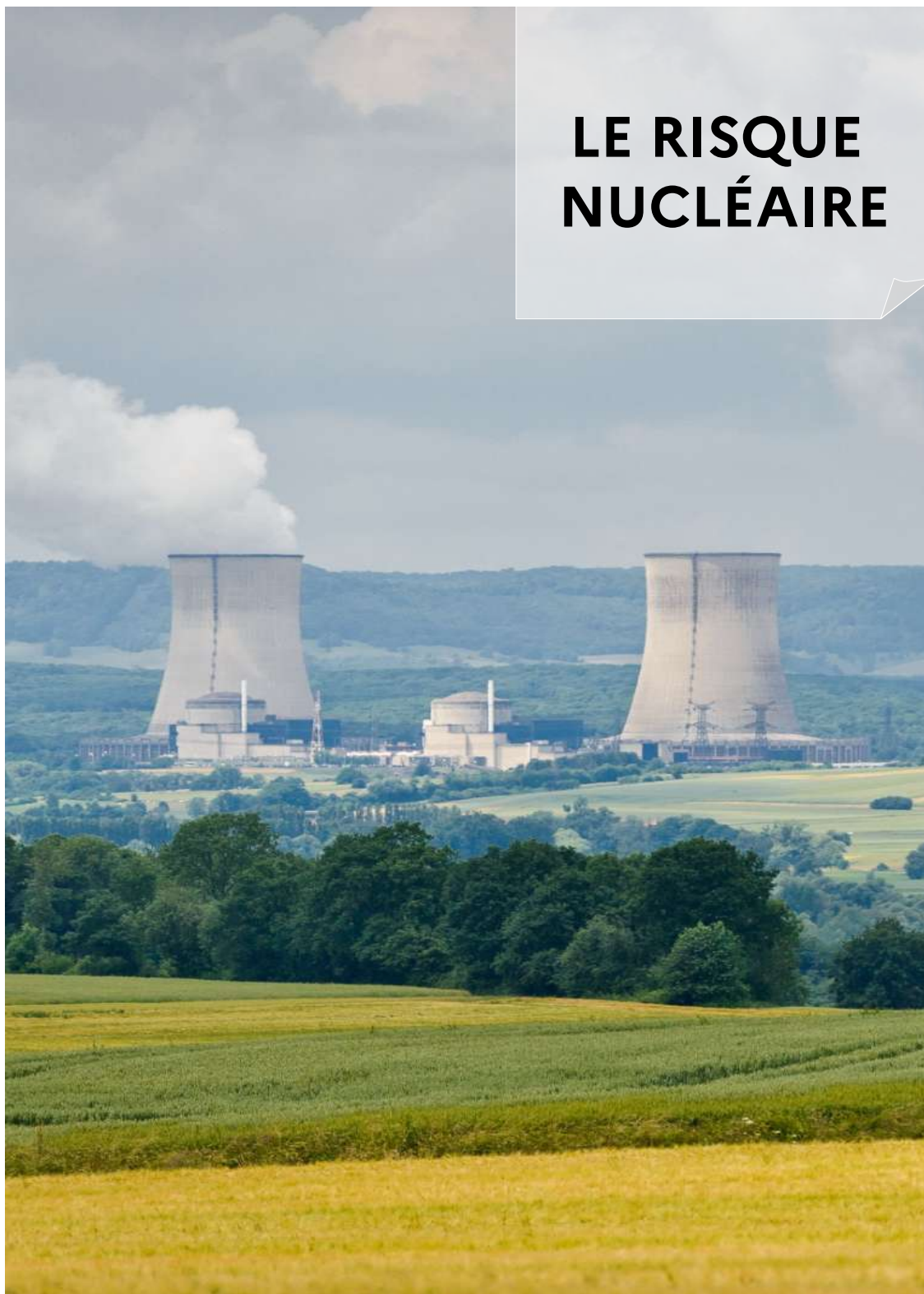
Centrale nucléaire de Cattenom en Moselle – Photothèque MTE
