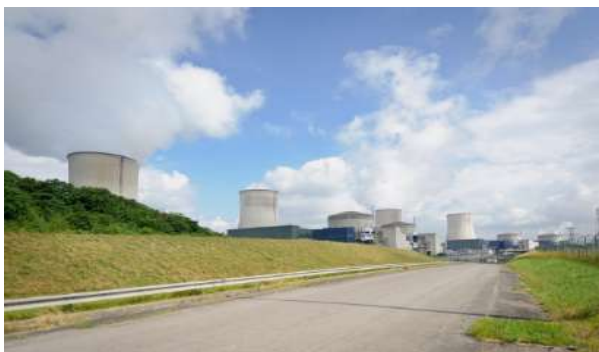
Centrale nucléaire de Cattenom en Moselle Photothèque MTE
