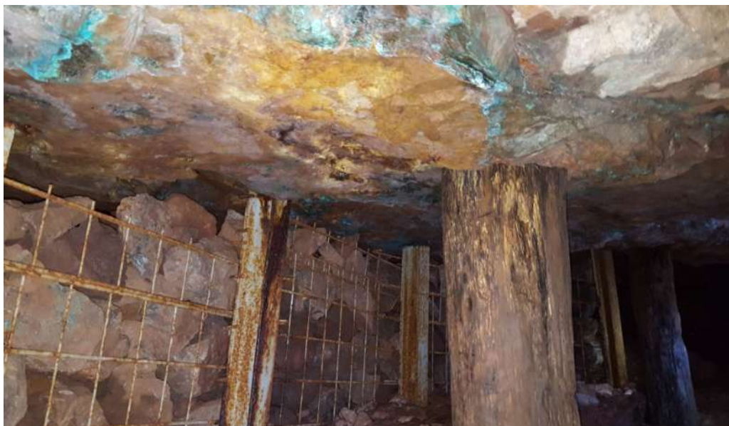
Galerie des mines de cuivre du Thillot - Photographie DDT88
