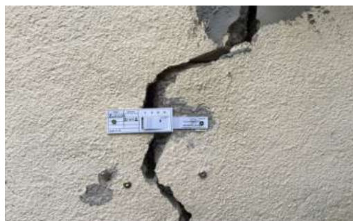
Témoin de fissuration d'une habitation suite à un retrait-gonflement argileux – Photographie MTE
